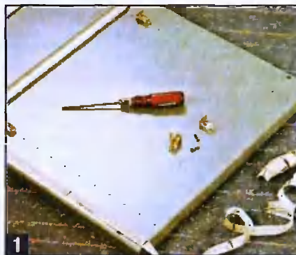
1 Монтаж полкодержателей и направляющих для выдвижных ящиков.
