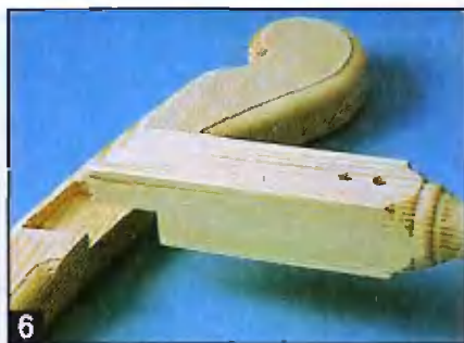
6 Полозья колыбели соединяют с угловыми стойками врубкой вполдерева.
