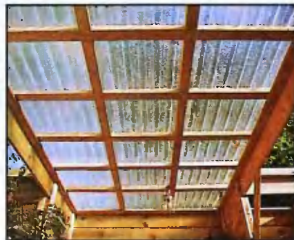
Кровля — из листов прозрачного гофрированного пластика, привернутых оцинкованными шурупами к обрешетке. Бруски обрешетки в местах пересечений соединены вполдерева.
