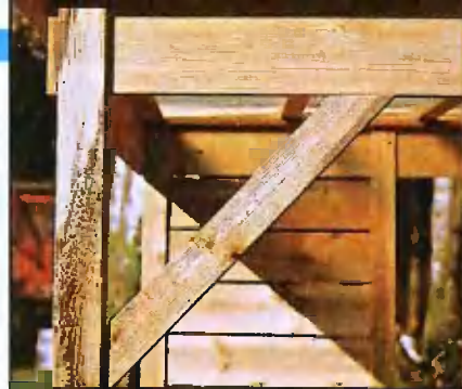
Остов навеса для лучшей устойчивости укреплен по углам подкосами.
