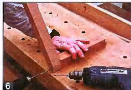
6 Сборка планок и перемычки крестовины.
